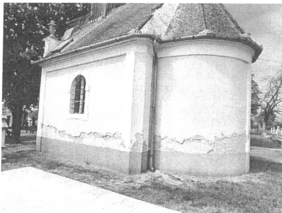
déli, dél-keleti homlokzat
